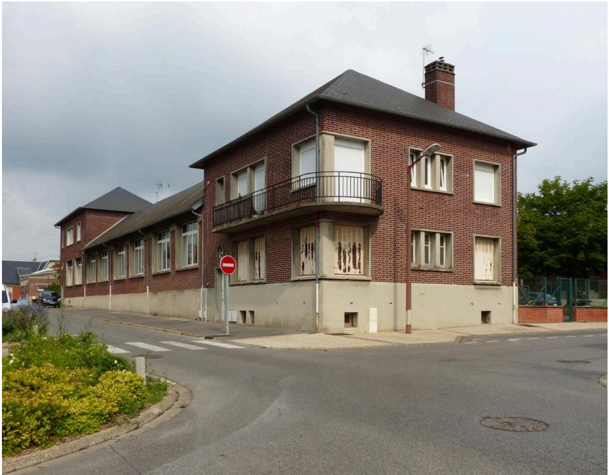
Les bâtiments de l'ancienne école de filles, reconstruits dans les années 1940.
