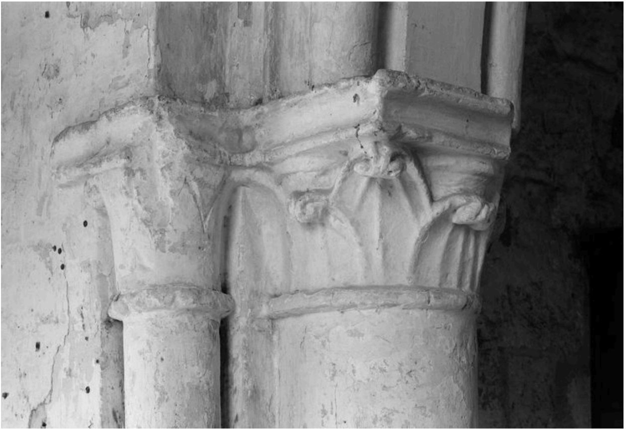
Bas-côté sud : détail d'un chapiteau.
