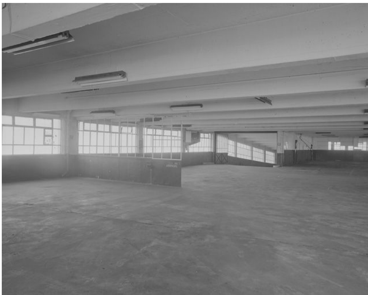
Vue d'ensemble du niveau 3.
