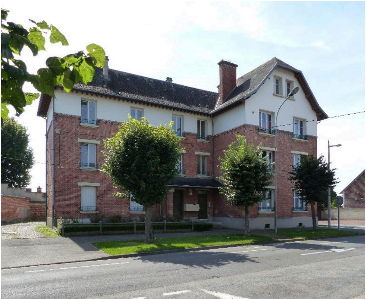
Les logements des instituteurs et des institutrices (ancienne école de filles).
