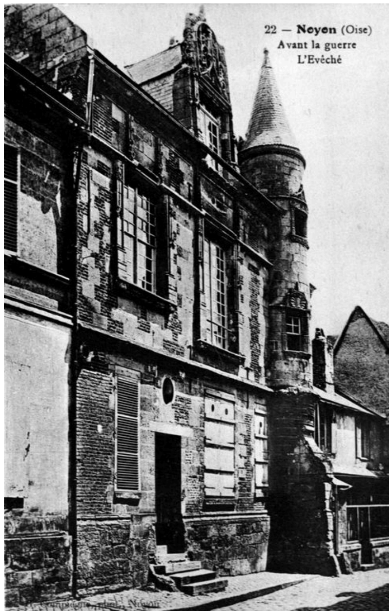
Aile du 16e siècle. Elévation sur rue, avant 1914 (AP).
