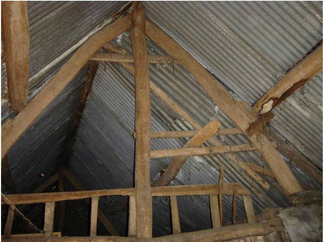
Vue détaillée de la charpente des dépendances.
