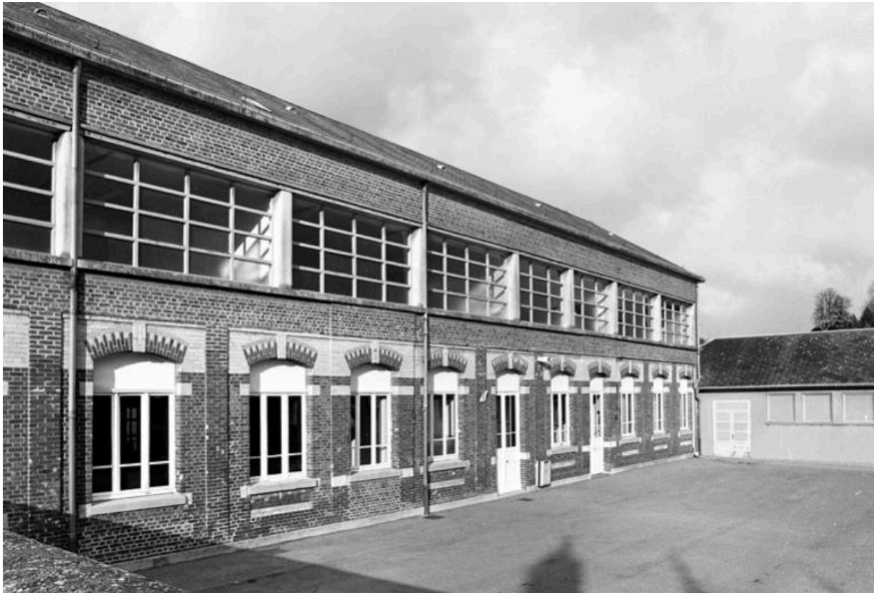
Vue de la façade sur cour du bâtiment des classes (surélevé d'un niveau en 1951).
