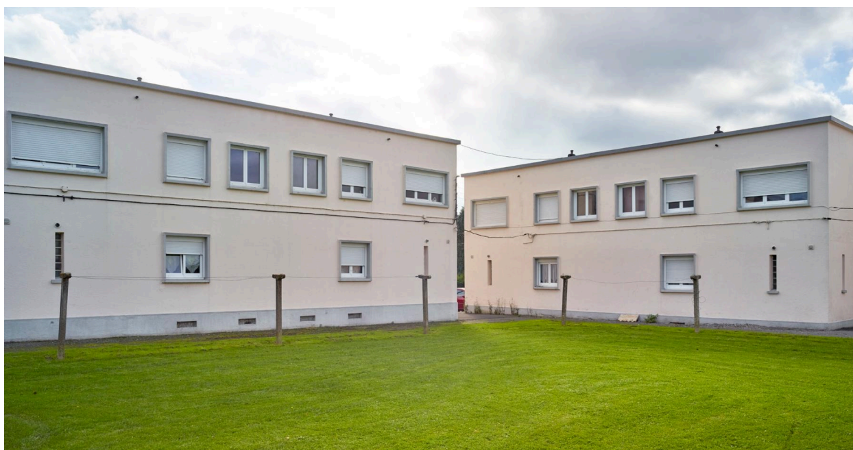
Vue arrière des pavillons, prise depuis les jardins.
