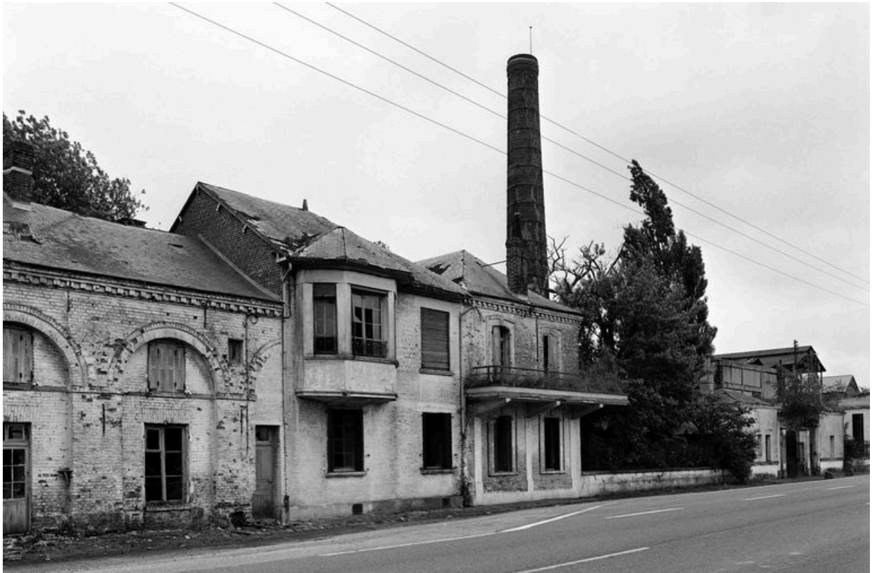
Logement patronal : élévation antérieure, façade ouest.
