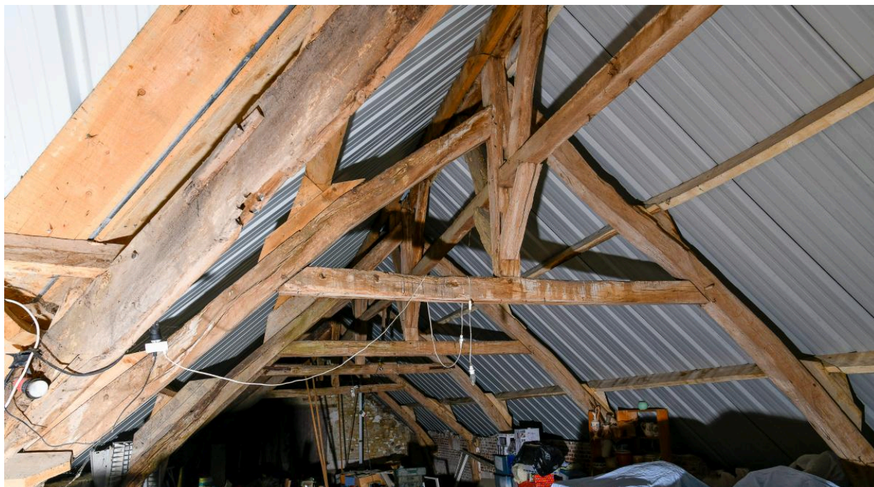
Charpente de l'ancienne écurie.
