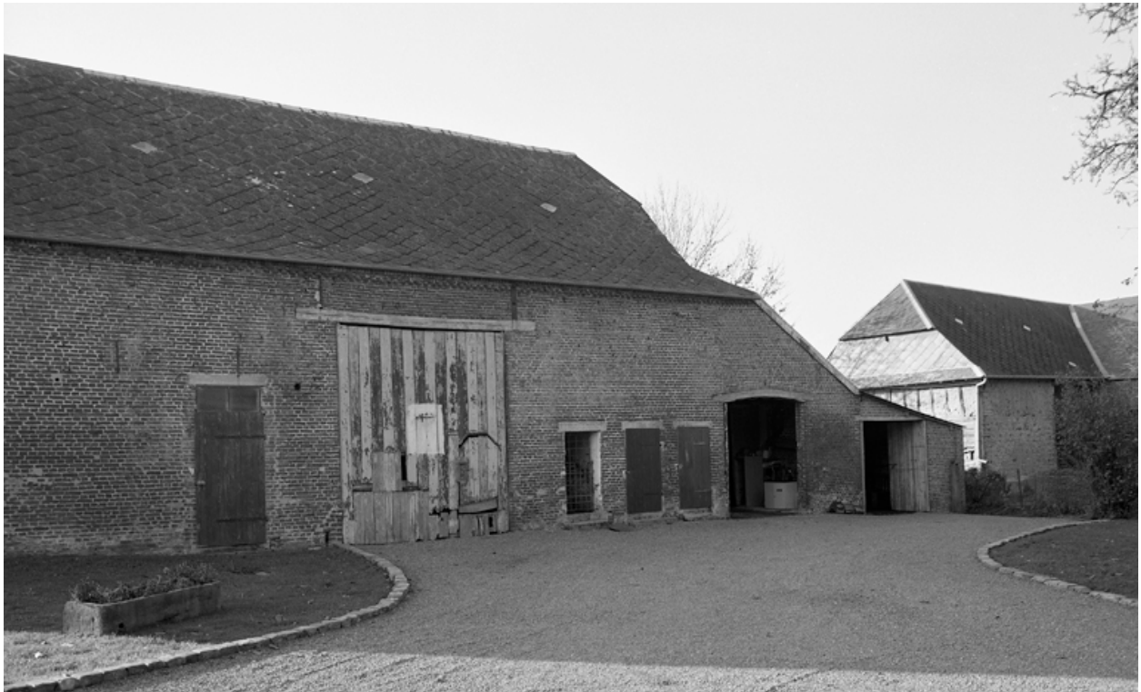
Vue partielle de l'élévation sur cour du bâtiment à usage de grange, étable et remise.
