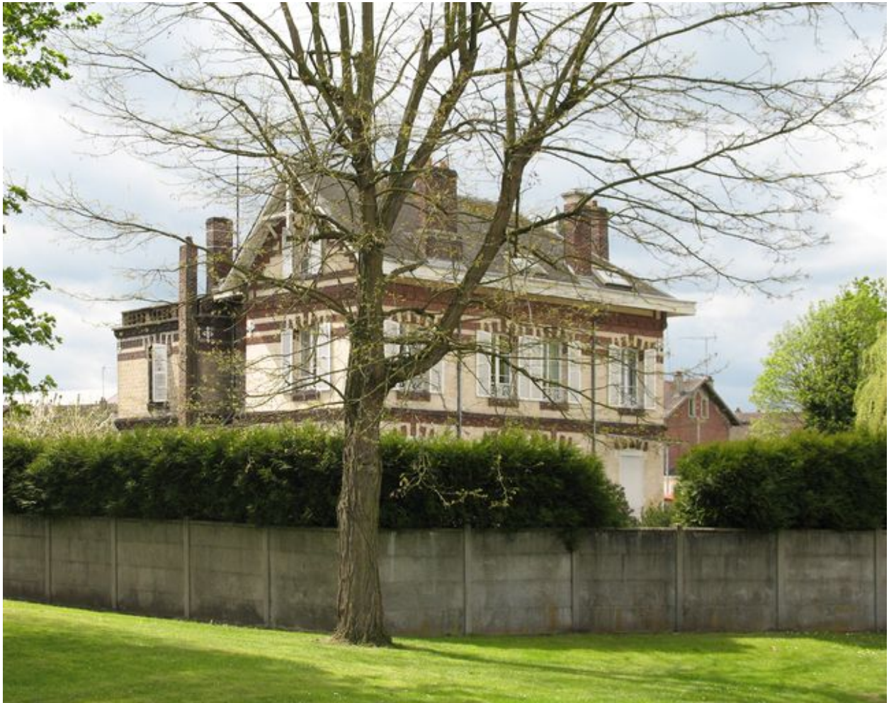
Vue du bâtiment abritant autrefois deux maisons d'ingénieurs.
