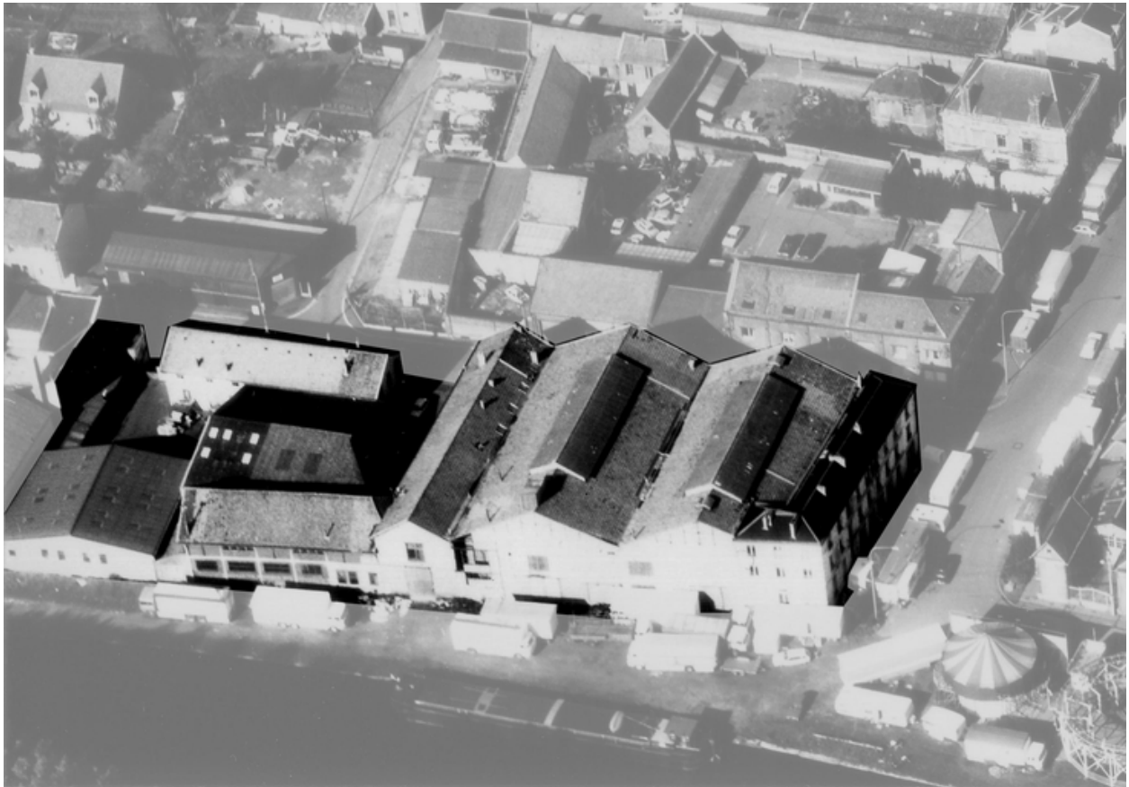
Vue aérienne du site de l'ancien tissage en 1989.
