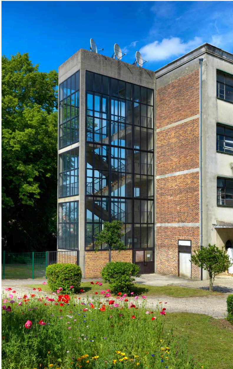
Cage d'escalier, vue extérieure.
