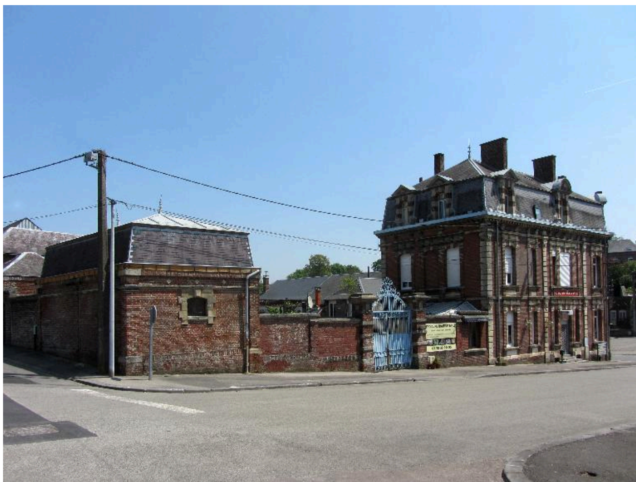
Vue d'ensemble de l'hôtel avec sa cour donnant sur la rue de l'Eglise.
