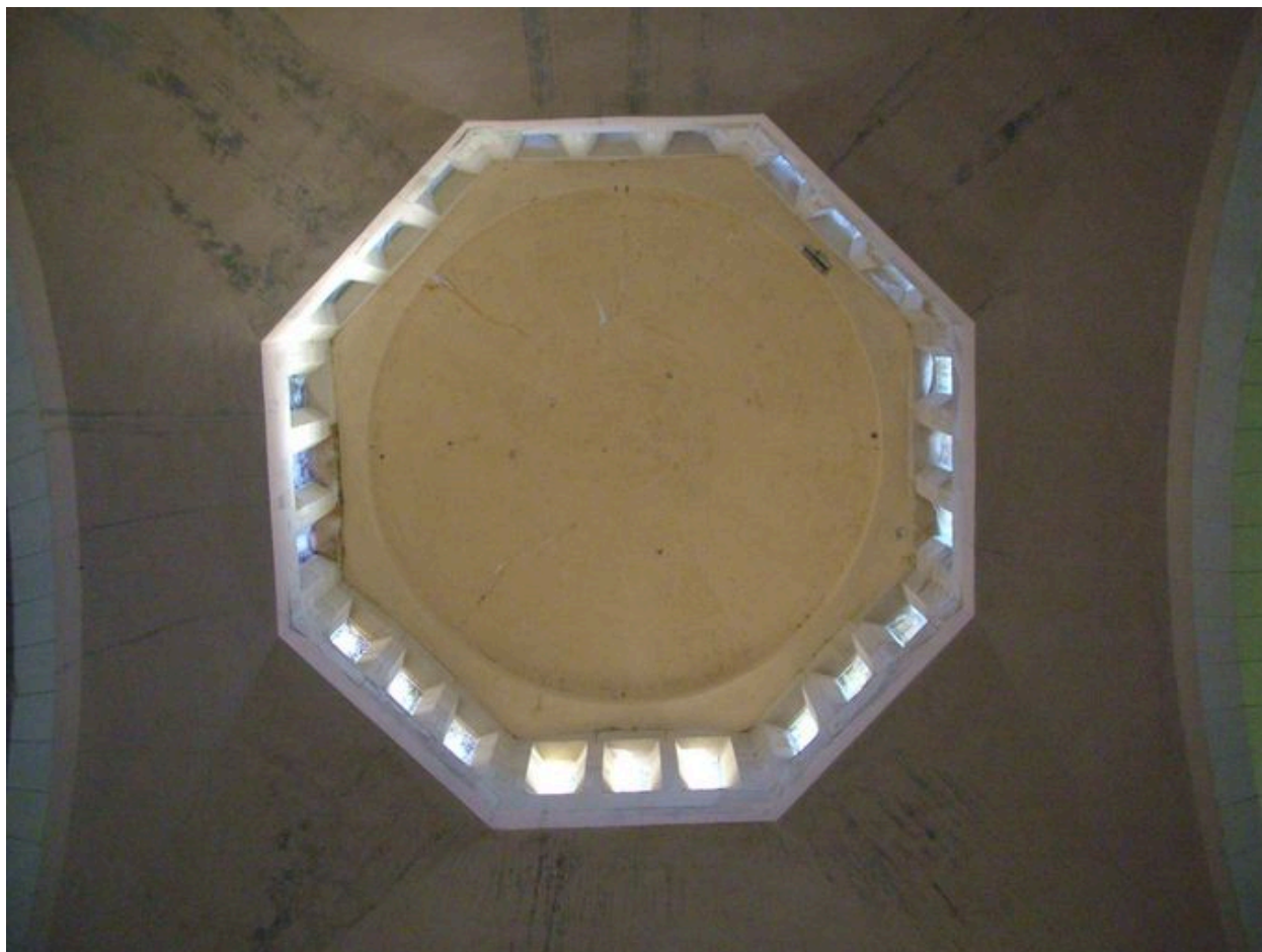
Vue inférieure de la coupole.
