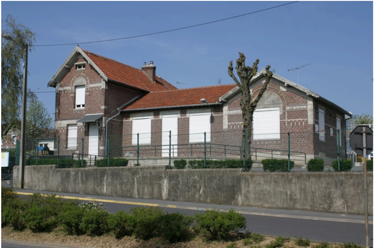
Façade antérieure de la pouponnière.
