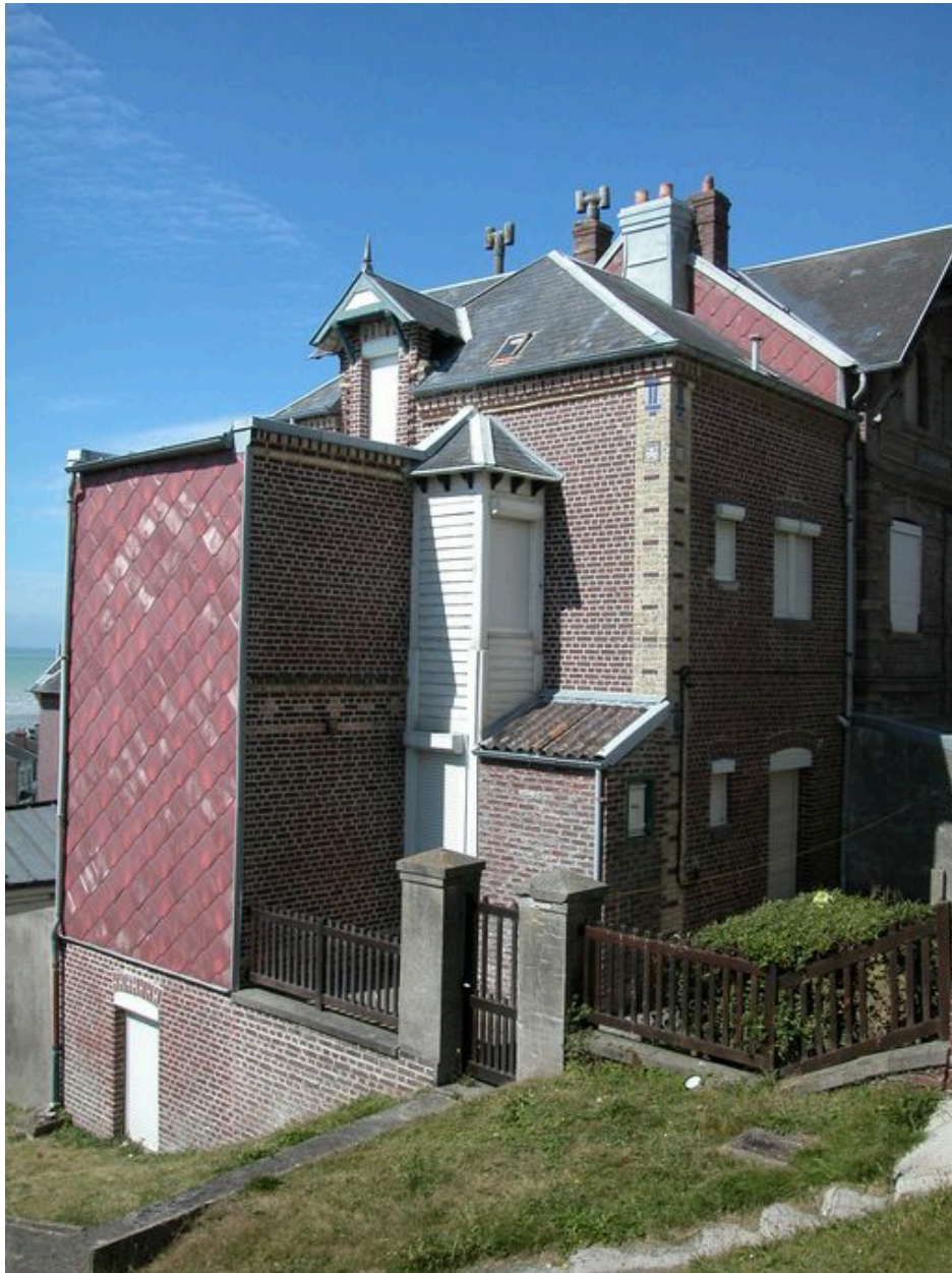
Vue de trois-quarts sur les élévations latérale gauche et postérieure, depuis l'avenue du Casino.
