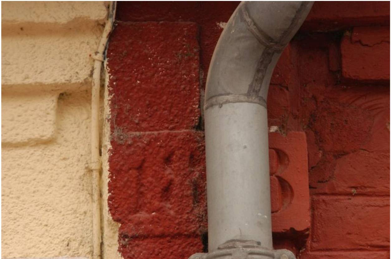
Maison, 14 rue Saint-Maurice, détail sur la date portée : 1883.
