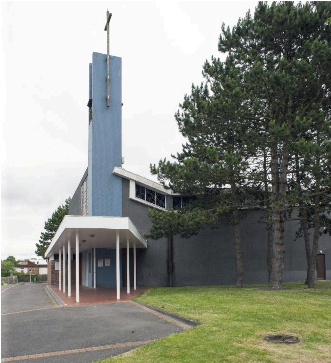
Vue de profil de la galerie devant la façade antérieure et flanc droit.
