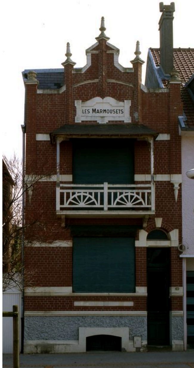
Pignon en façade ouvragé (Les Marmousets, 973 avenue de la Plage).
