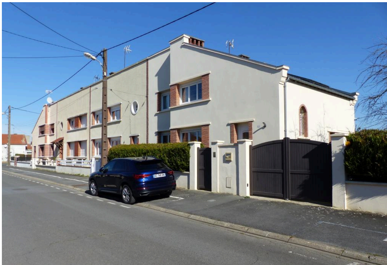
Maison à quatre unités d'habitation, 12 à 18 boulevard de la Liberté.
