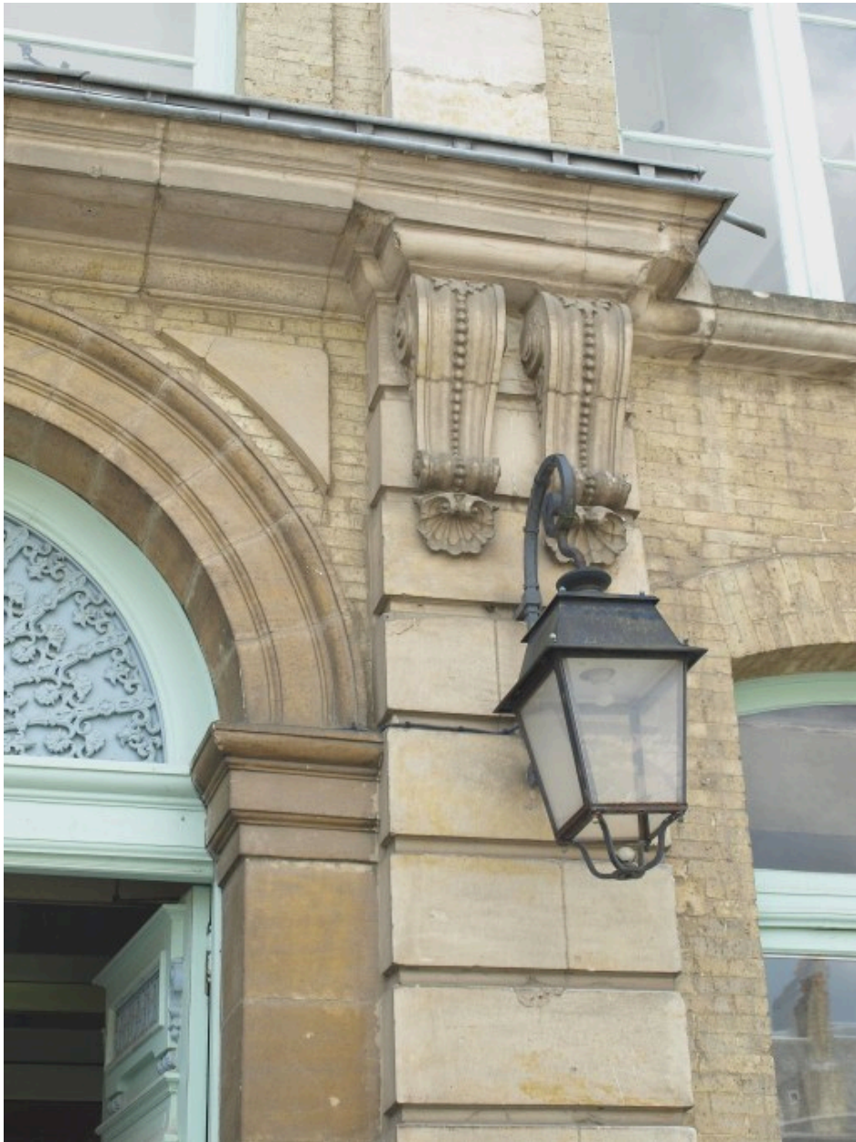
Détail sur la façade du bâtiment principal
