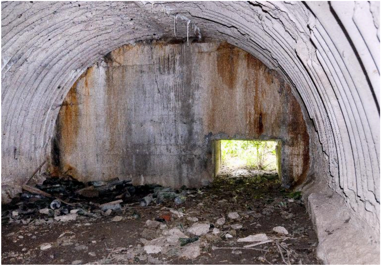
Bâtiment A, vue intérieure
