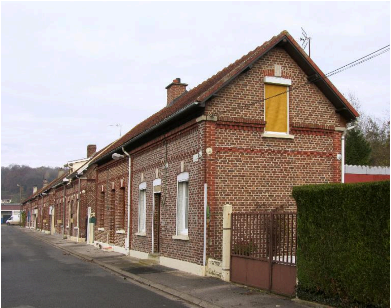
Vue d'ensemble de la cité ouvrière.
