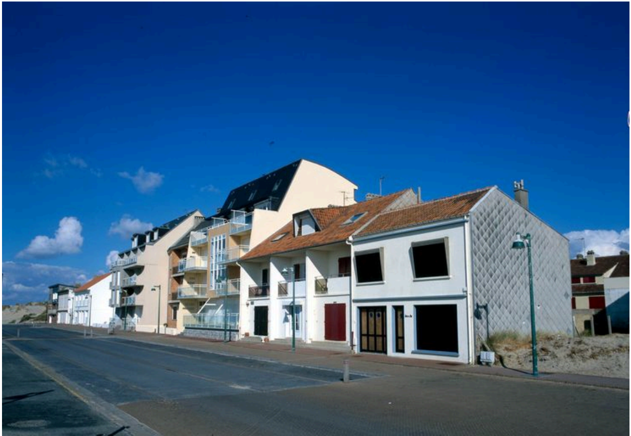
Les constructions de la digue nord.
