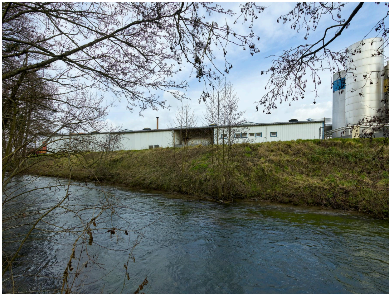
Vue des halles de fabrication de l'usine de produits chimiques Acia depuis la rive opposée de l'Authie.
