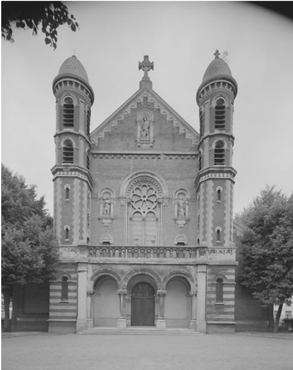
Vue de la façade ouest (liturgique).
