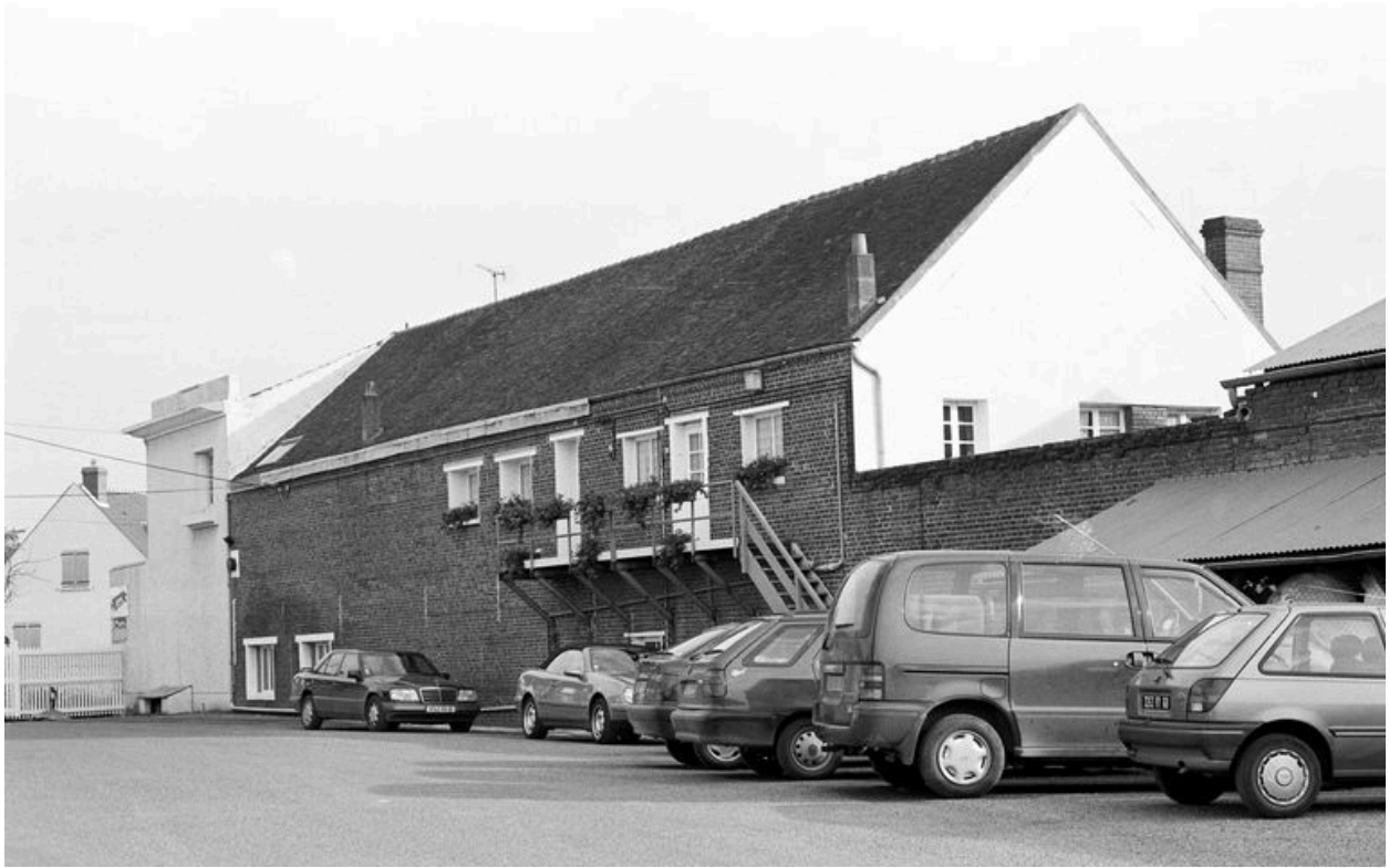
Façade nord de l'ancienne conciergerie, convertie en atelier de réparation et logement d'ouvriers.
