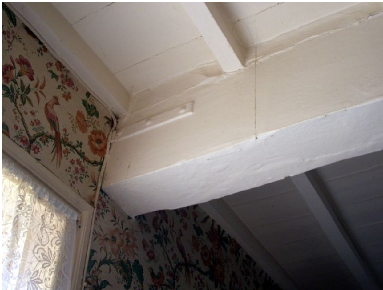
Vue détaillée d'une des poutres de la salle avec tirant.
