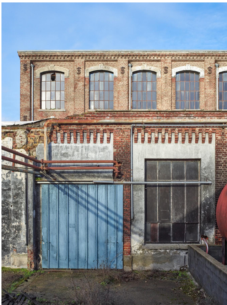
Élévation partielle sud de l'ancien atelier de fabrication (bâtiment K).
