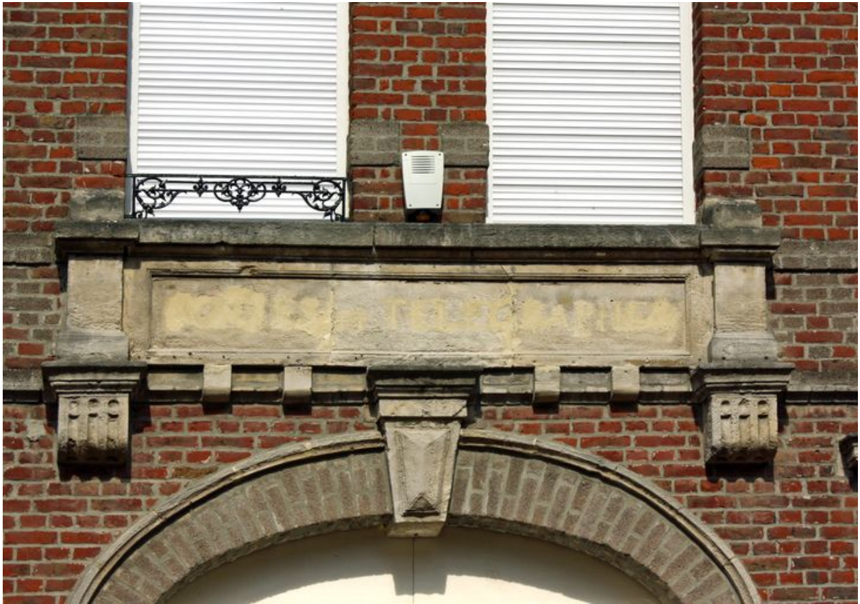
Ancienne poste. Inscription sur la façade : Poste et Télégraphes.
