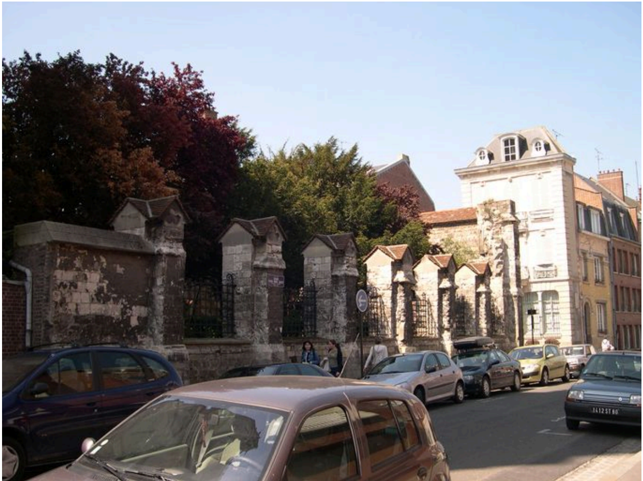
Vestiges de l'ancienne église conventuelle, façade nord.
