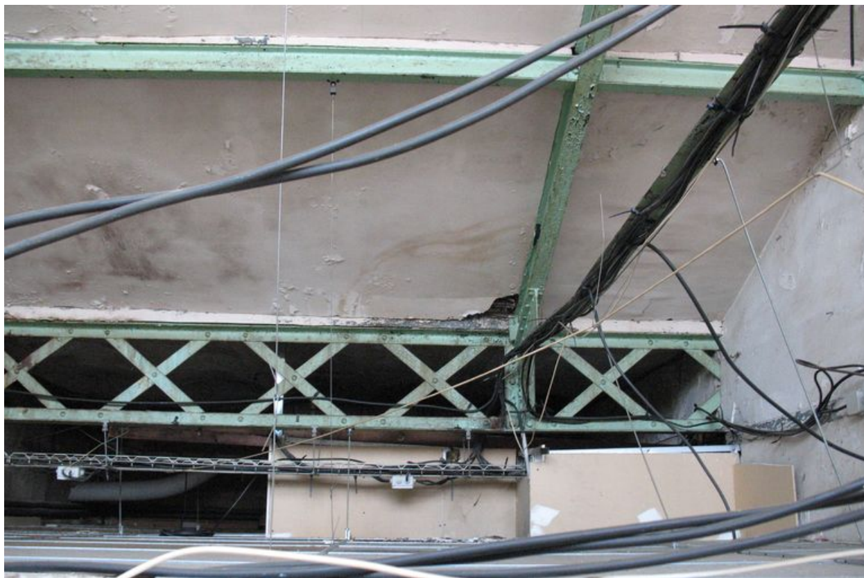
Détail d'une poutrelle métallique sous les sheds.
