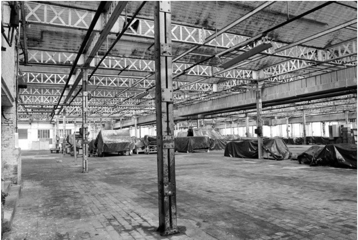
Atelier de préparation de la filature, vue intérieure.
