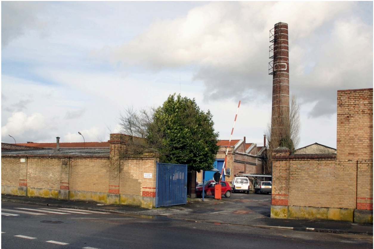
Entrée secondaire de l'usine.
