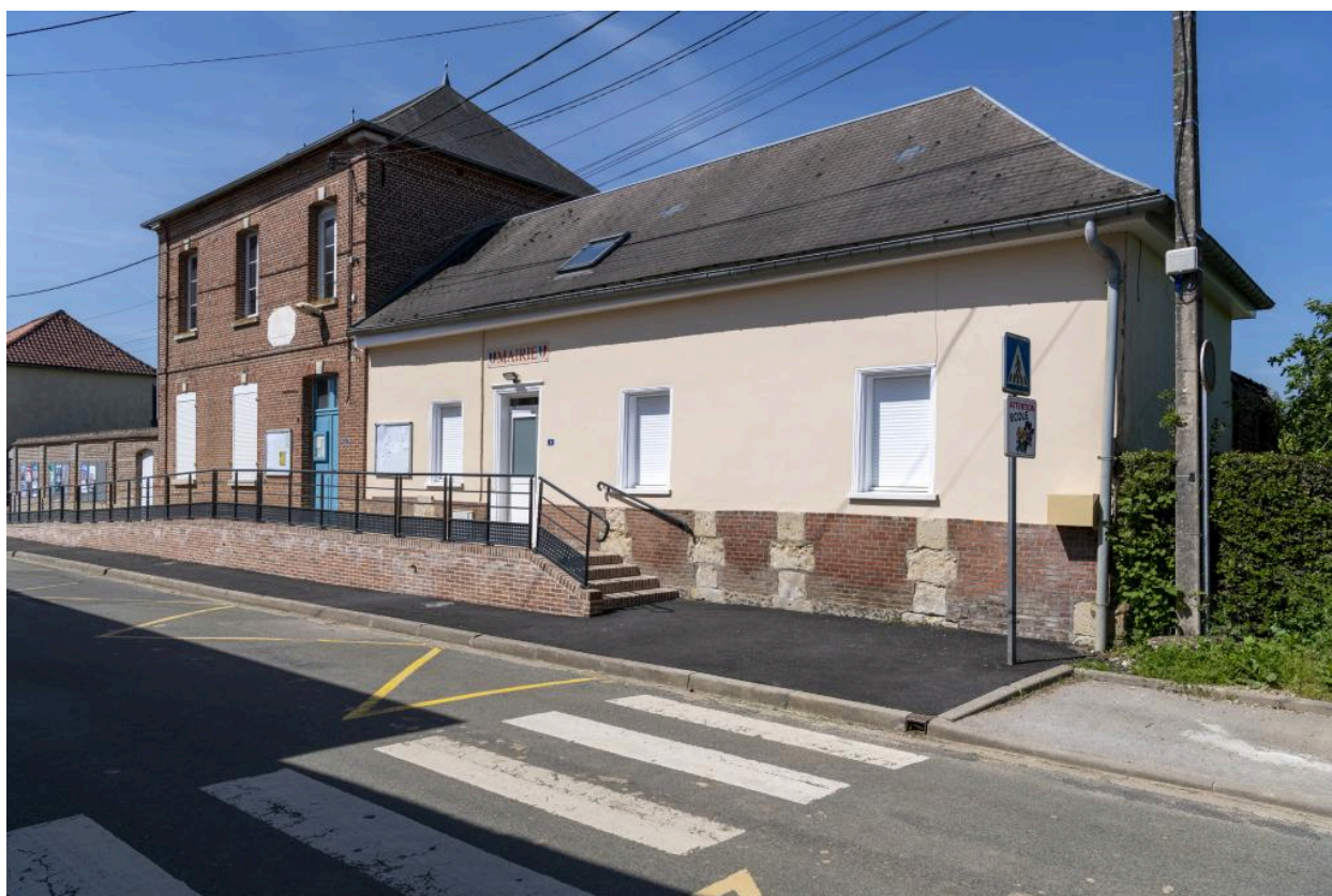
Mairie-école, n°4 rue Léger, vue de la façade sur rue.
