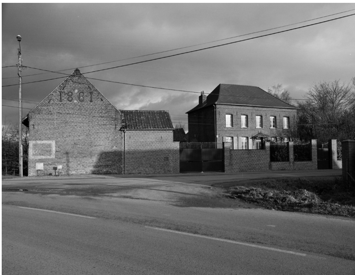
Ferme, 13 rue du Grand Rosult, vue générale.
