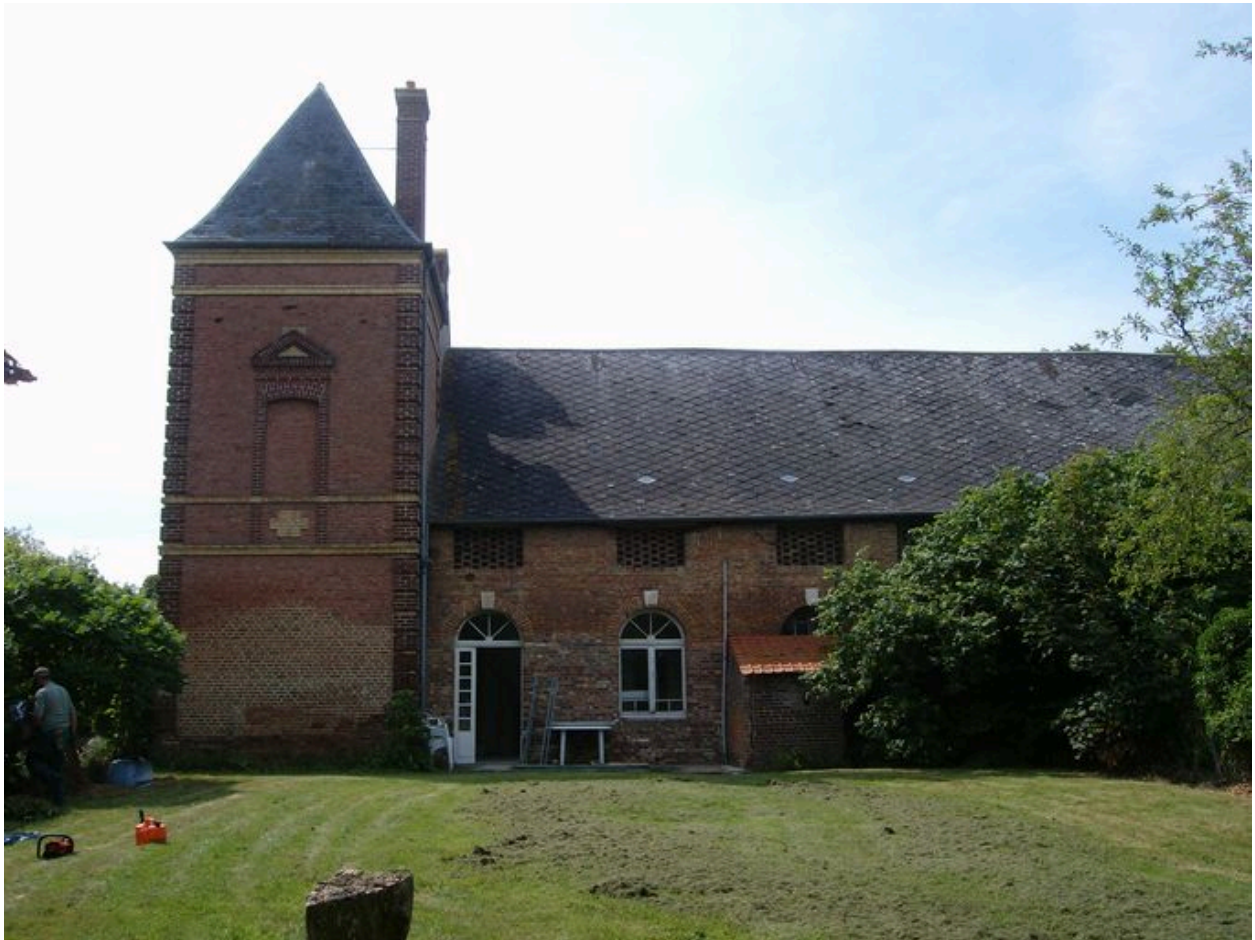
Vue latérale de la ferme.
