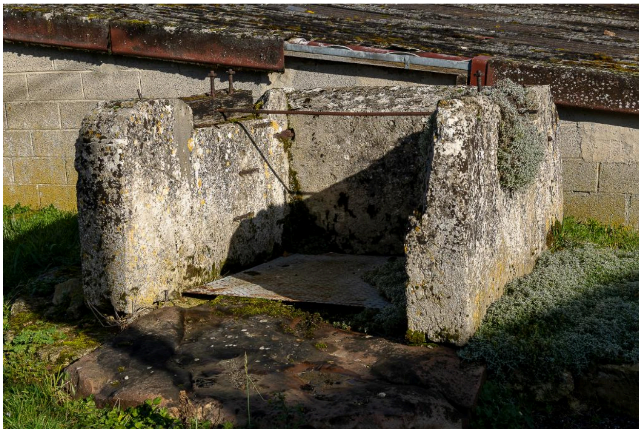
Anciens puits rue du Moulin.
