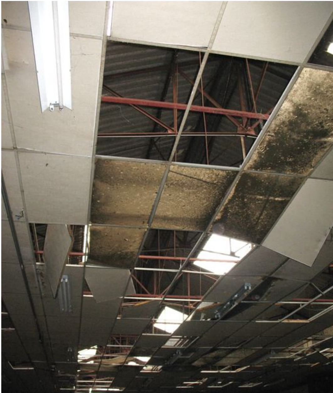
Le faux-plafond et la charpente métallique.
