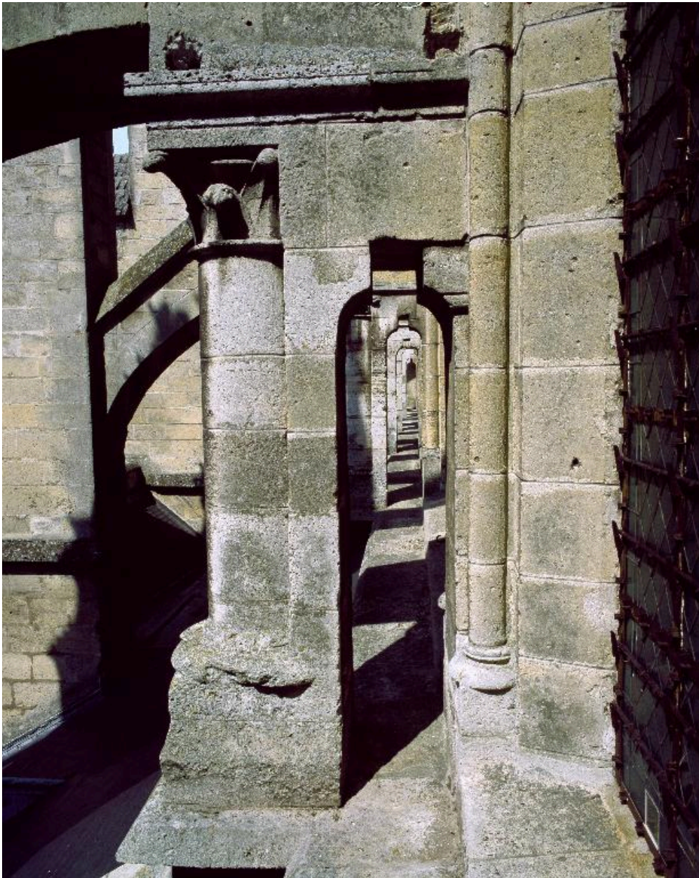
Vue du passage extérieur qui longe les fenêtres hautes de la nef.
