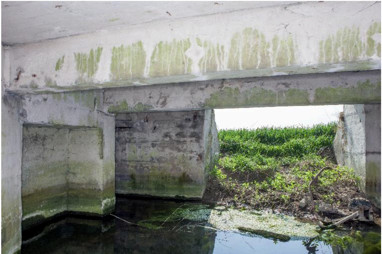
Vue intérieure de la chambre de tir, vers l'arrière. A gauche, l'accès à la soute à munitions
