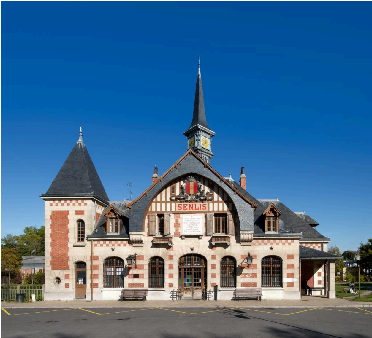
Vue d'ensemble de face de la façade donnant sur la place de la Gare.
