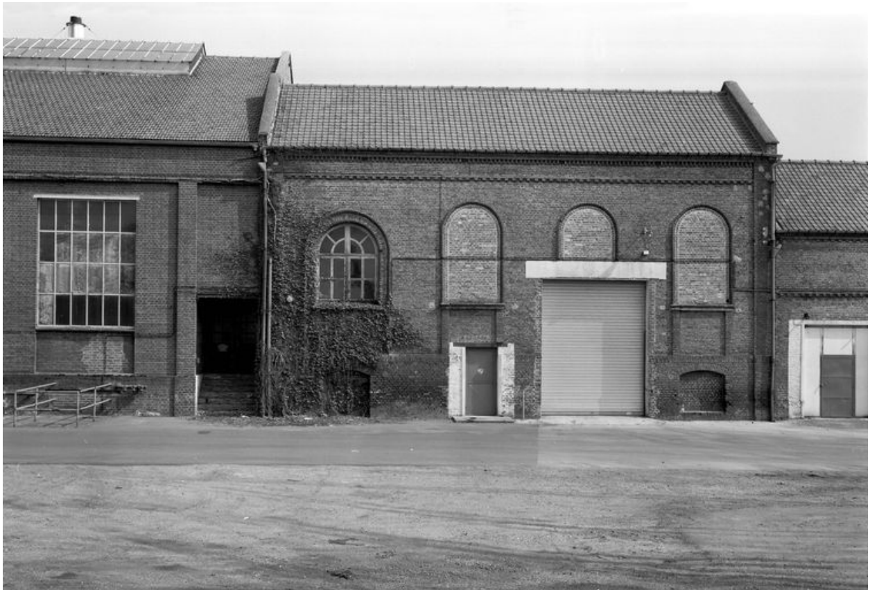
Façade sud de la salle des machines, état en 1988.
