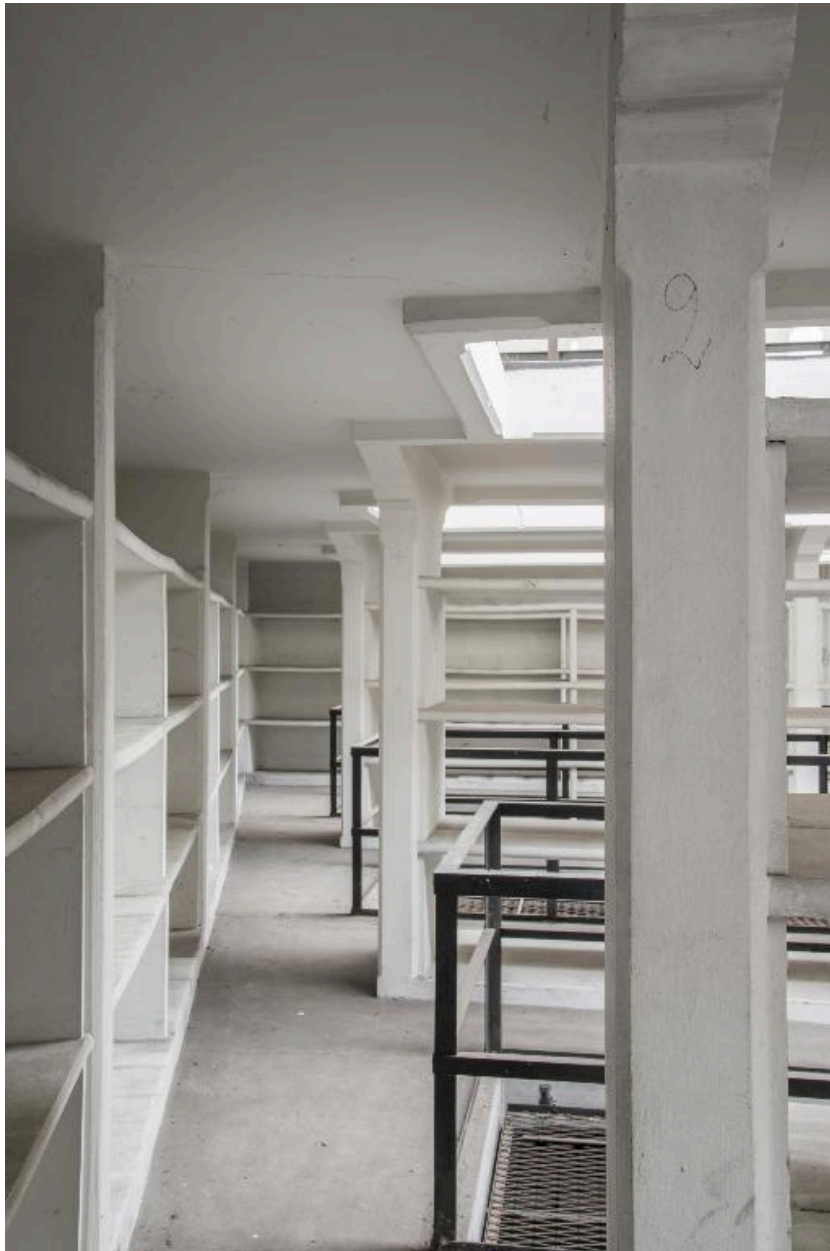
Bâtiment du dépôt, deuxième étage : vue des rayonnages côté ouest et de l'extrémité des vaisseaux 1, 2 et 3.
