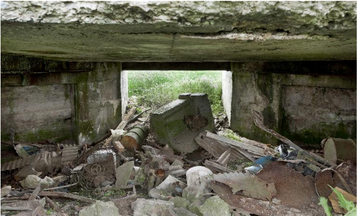
Chambre de tir, vers le front
