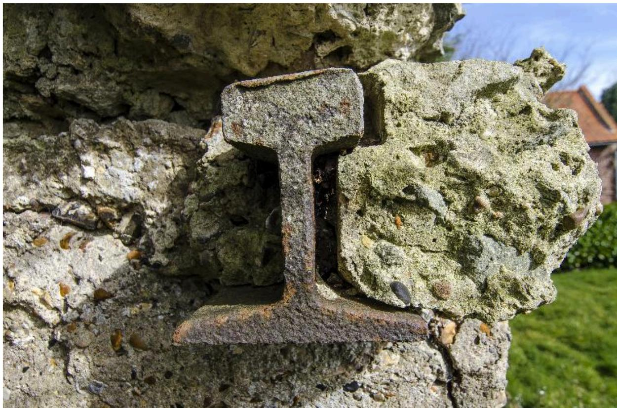
Profil d'un rail servant de soutènement longitudinal aux fers en I
