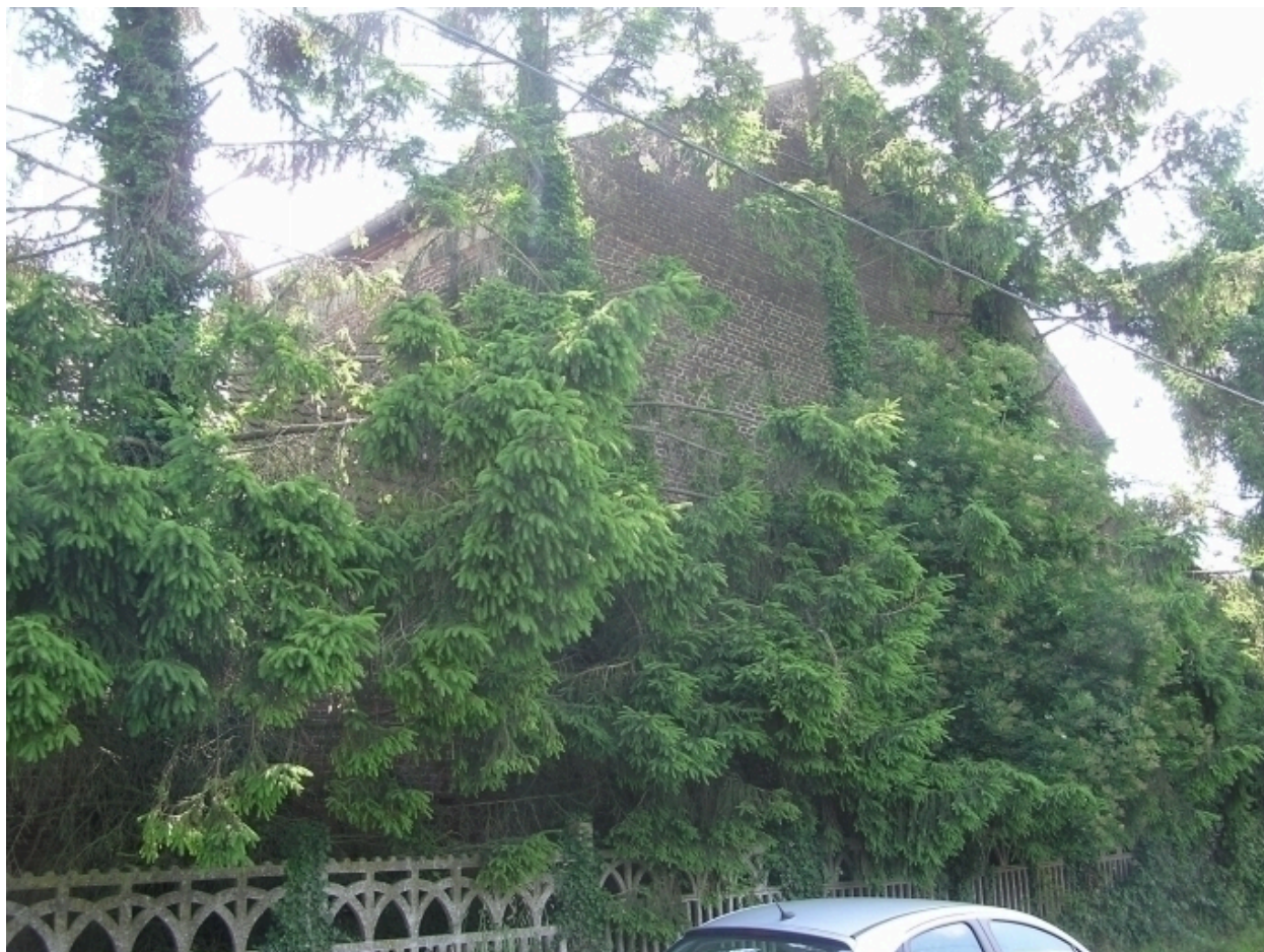
Vue d'un pignon de la grange.
