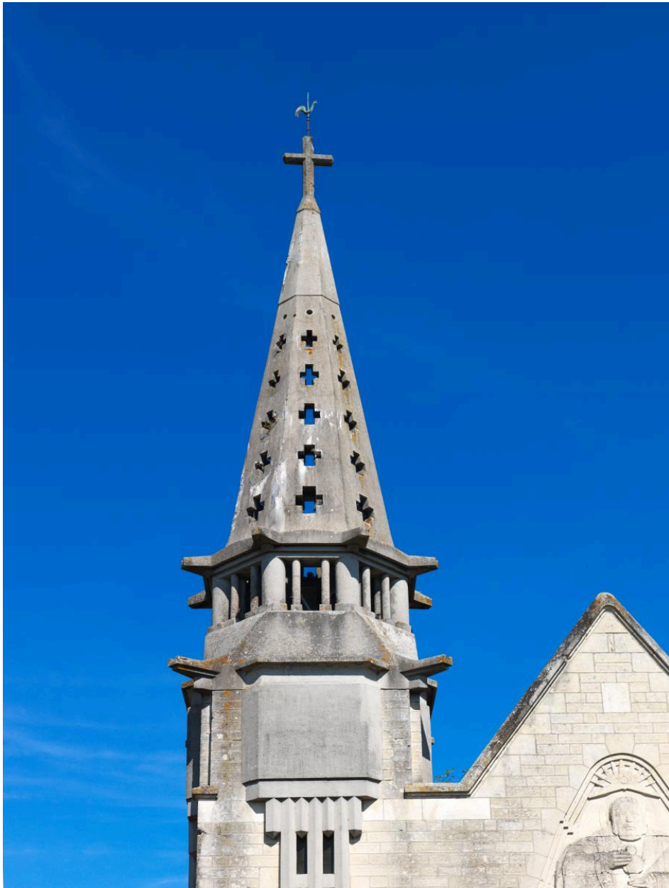
Vue de la partie supérieure du clocher.
